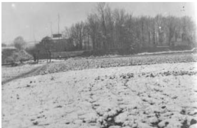
Vista general de la Torre Castanys. 1899.
